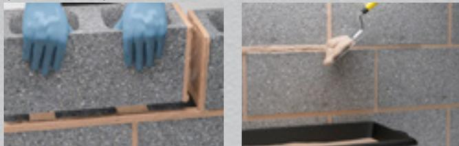
5. Para o assentamento de alvenaria, aplique a **ARGAMASSA MULTIUSO ASSENTAMAIS** sobre os blocos com colher de pedreiro e posicione o bloco sobre a argamassa fresca.
