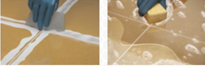
5. Com a espátula dobrada de forma a unir as duas pontas, frise o rejuntamento para garantir total penetração nas juntas, removendo todas as bolhas de ar.
