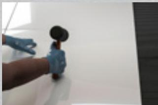
5. Assente as peças cerâmicas sobre os cordões da **ARGAMASSA COLANTE FLEXÍVEL ASSENTAMAISS AC-II**, fazendo-as deslizar um pouco até a posição final.
