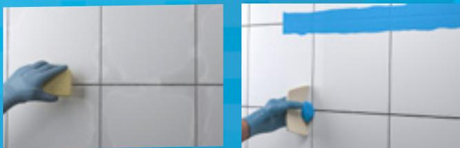
3. Com o auxílio de um pequeno rodo de borracha ou espátula de plástico flexível, pressione o produto sobre as juntas a fim de obter uma perfeita penetração.
