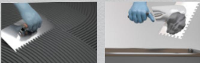
3. Em seguida, passe o lado denteado da desempenadeira de 8 mm X 8 mm X 8 mm de espessura, formando sulcos ou cordões.
