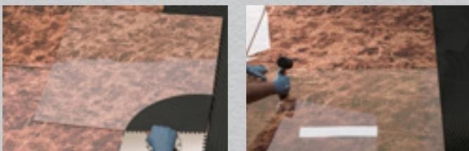
5. Placas com área igual ou superior a 900 cm<sup>2</sup> (exemplo 30 cm X 30 cm) em áreas internas e placas de qualquer dimensão em áreas externas e pisos de alto tráfego, deverão receber uma aplicação da **ARGAMASSA COLANTE MÁRMORE E GRANITO ASSENTAMAI**S em seu verso. Com a desempenadeira denteada de 8 mm X 8 mm X 8 mm, os cordões deverão ser cruzados com os da superfície a ser revestida.
