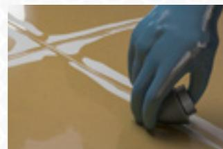
3. Retire a embalagem plástica contida no balde e recorte uma das pontas, utilizando-a como aplicador para preencher as juntas entre os revestimentos.
